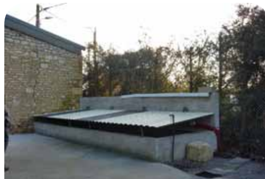
PHYTOBAC® réalisé par auto construction
