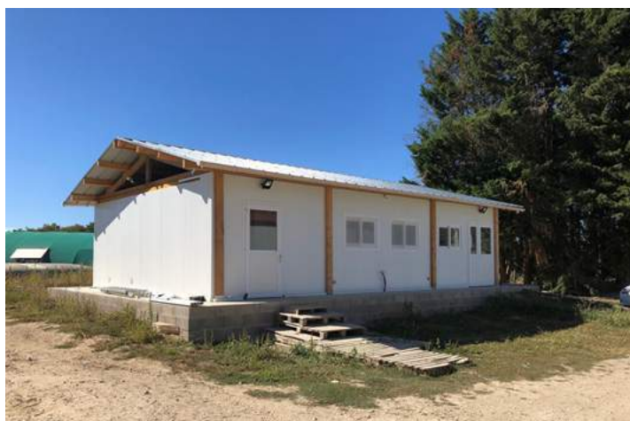
Photo 18 : Fromagerie en panneaux sandwich avant bardage bois
