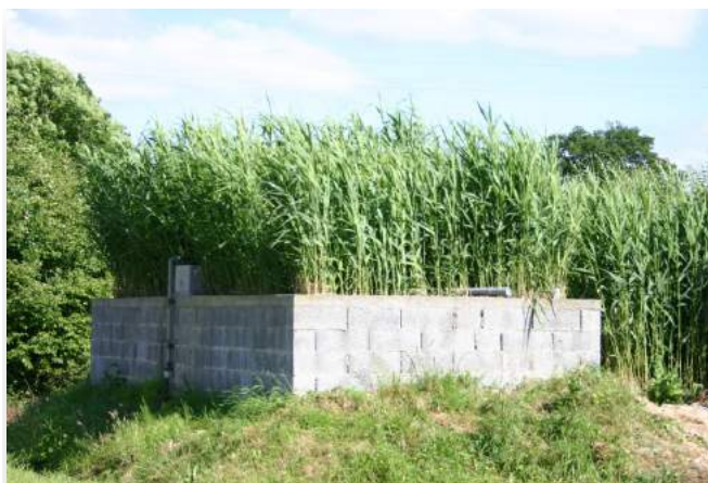
Photo 22 : Le traitement des effluents par les roseaux
