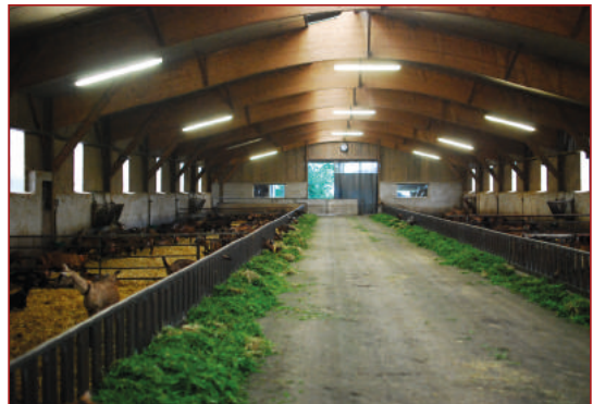
Chèvrerie traversante et large, permettant un passage facile de l'autochargeuse.
