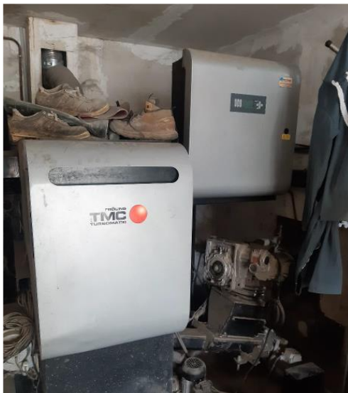
Chaudière à copeaux de bois et local de stockage des copeaux. Source Eilyps
