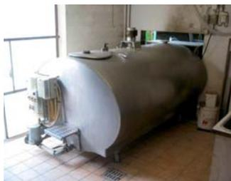
La disposition du tank doit être réfléchi. La laiterie doit être isolée et ventilée par une entrée d'air basse et une sortie d'air haute (fenêtres de 1 x 0,85 m équipées de moustiquaire). Les condenseurs doivent être orientés vers une ouverture ou placés à l'extérieur (éviter l'exposition au soleil). Un espace d'au moins 70 cm doit être laissé autour de la cuve pour l'entretien. Le dispositif de vidange du tank doit se trouver près de la porte d'entrée.
