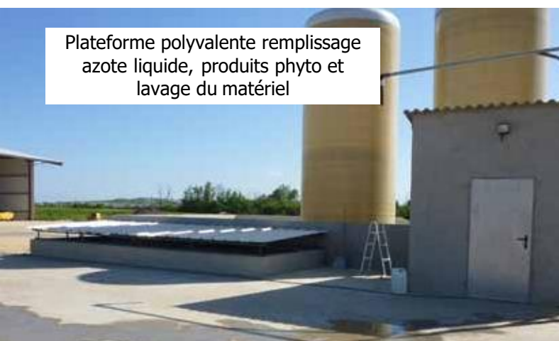
Une aire de lavage couverte évite de gérer les eaux de pluie
