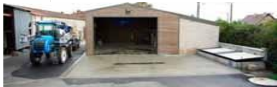
Plateforme couverte réservée au remplissage et plateforme de lavage du matériel situé à l'extérieur
