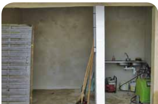
Zone de préparation
