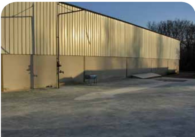
Aménagement d'une installation avec potence
